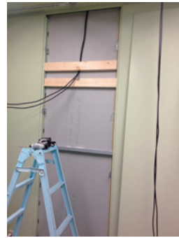
壁面補強工事例
