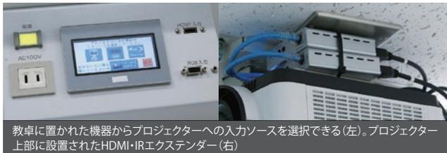
教卓に置かれた機器からプロジェクターへの入力ソースを選択できる(左)。プロジェクター上部に設置されたHDMI・IRエクステンダー(右)
