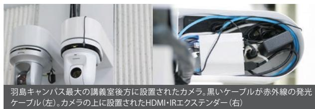
羽島キャンパス最大の講義室後方に設置されたカメラ。黒いケーブルが赤外線発光ケーブル(左)。カメラの上に設置されたHDMI・IRエクステンダー(右)
